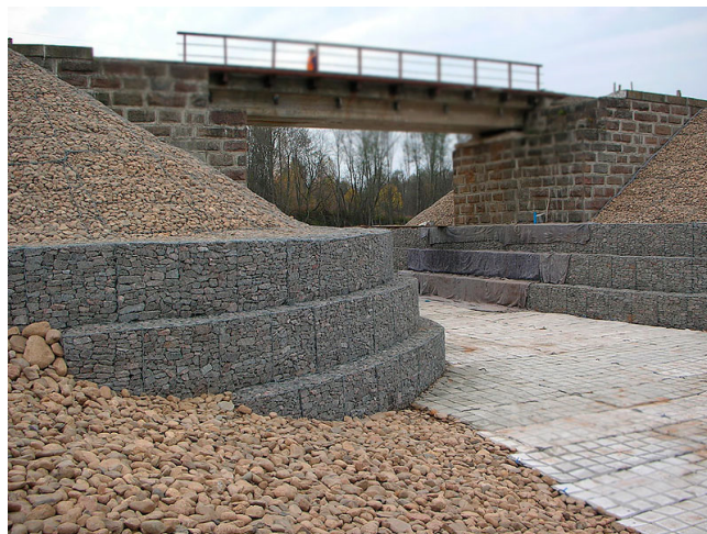
Рисунок 1 – Использование геомембраны в создании мостового и пешеходного перехода Источник: [1].
